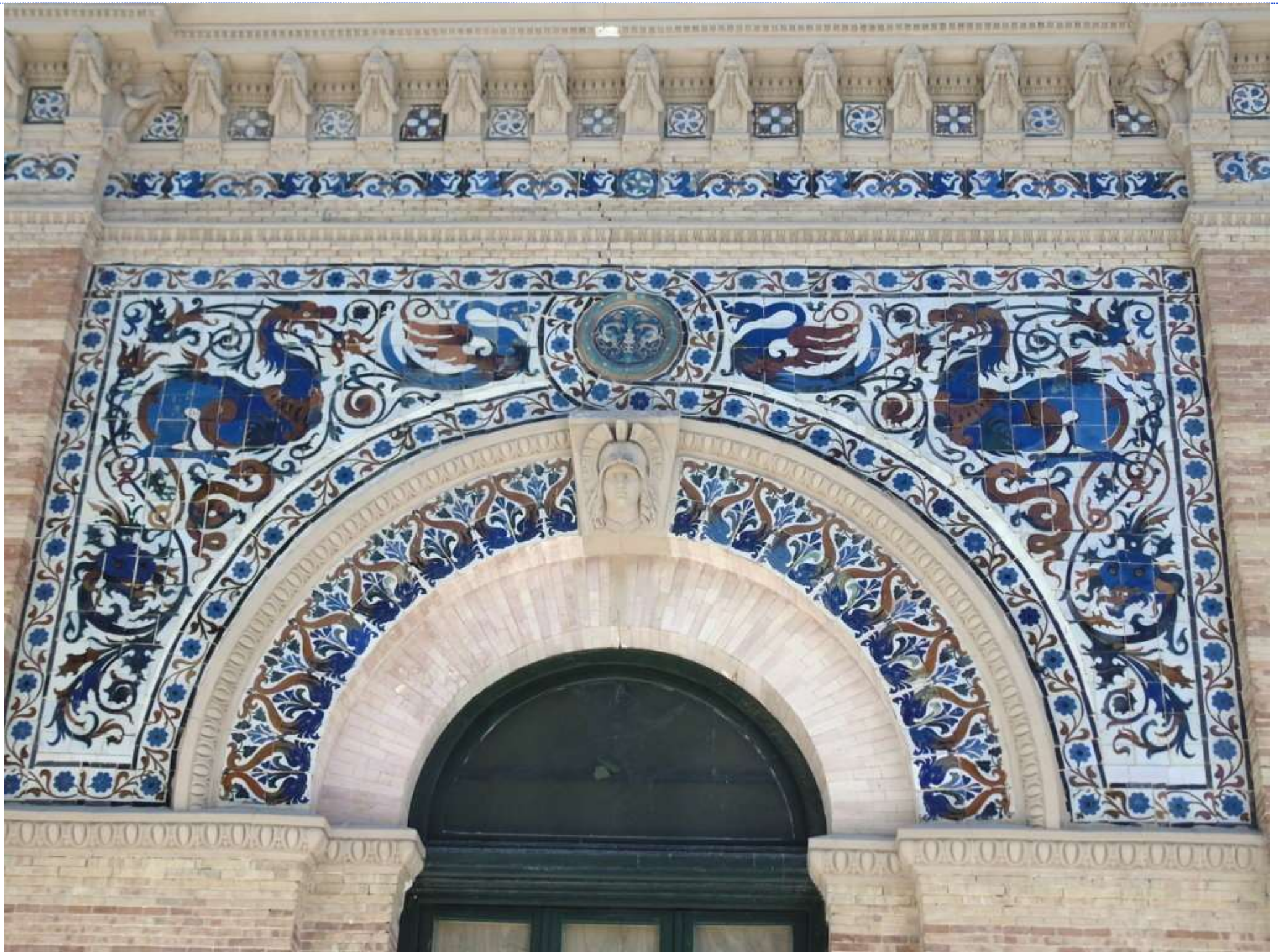
Fachada del Palacio de Velázquez del Retiro de Madrid
